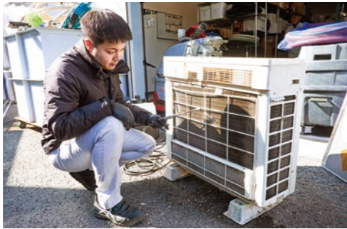
空調設備の洗浄・点検・修理に携わる社員は、電気工事士や冷凍機械責任者などの資格を持ち、実務に当たる。
