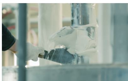
液状ポリマーと粉を均一に分散させる 「混練り工程」
