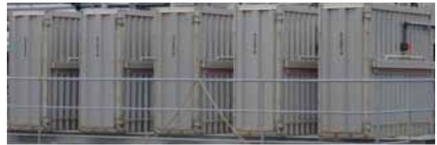
次世代型浸漬膜処理システム設置例 (処理能力 250m<sup>3</sup>/日)
