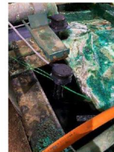
水位を測るセンサー(設置状態)
