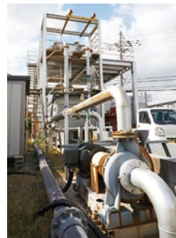
平成28年、「堺市ものづくり新事業チャレンジ支援補助金」の助成を受け敷地内に作ったマイクロ水力発電の実験装置。
