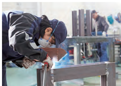
キュービクル架台の溶接作業。働きやすい環境の中、女性社員も活躍している。
