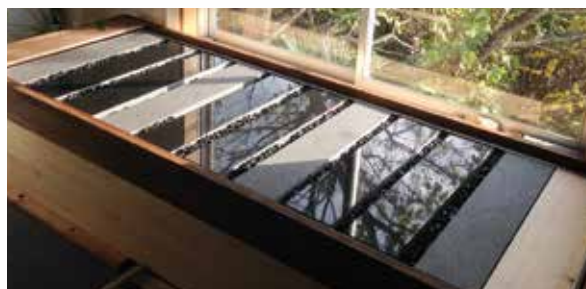
▲ヒーターの1ユニットは1畳ほどの大きさ。施工場所の広さに応じてフレキシブルに組み合わせられる。
